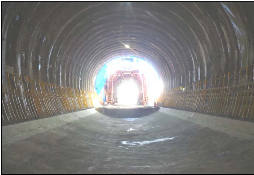
【避難坑 インバート工】
