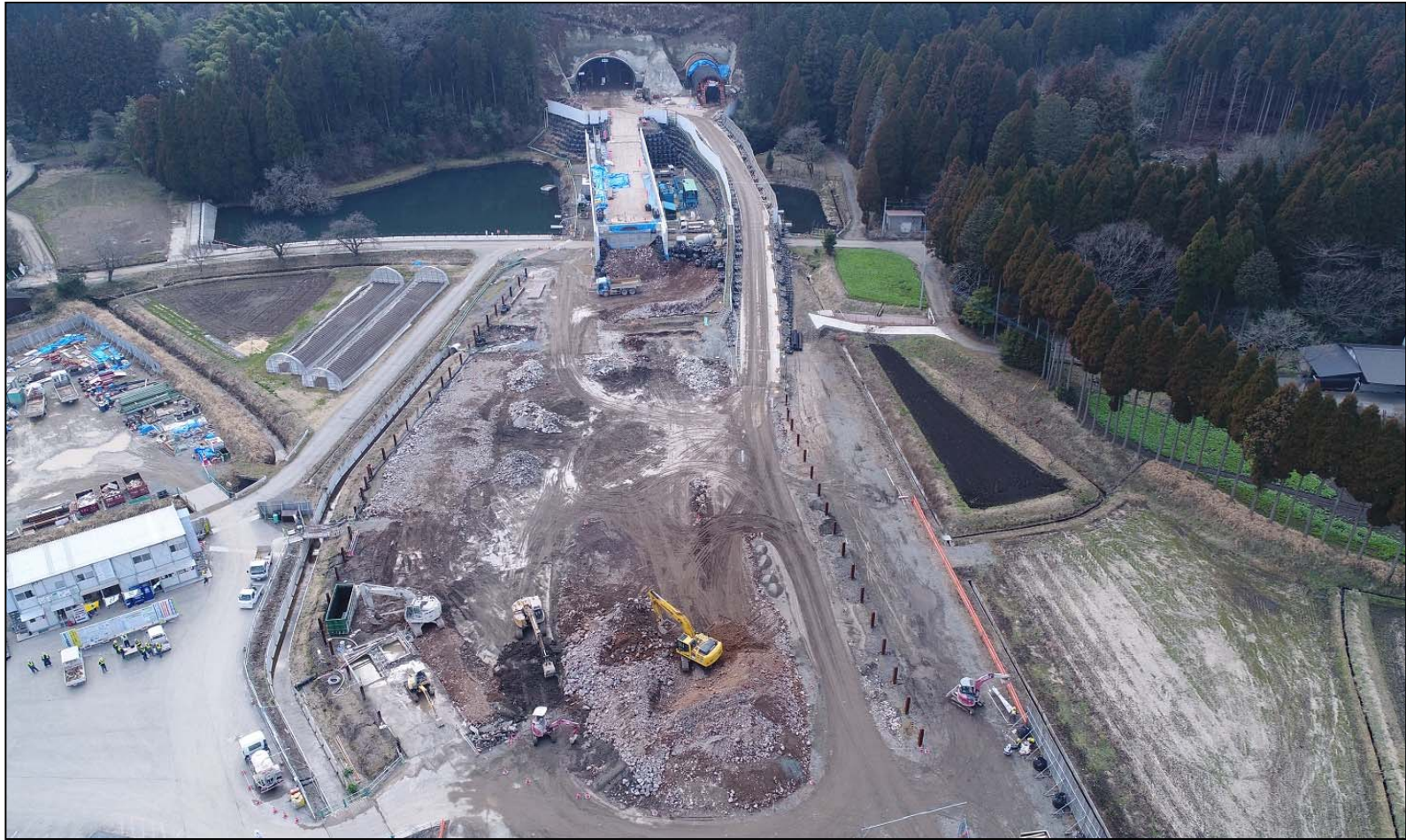
【仮設ヤード内状況】
