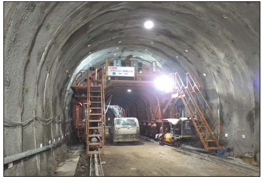
【避難坑 セントル（移動式型枠）】
