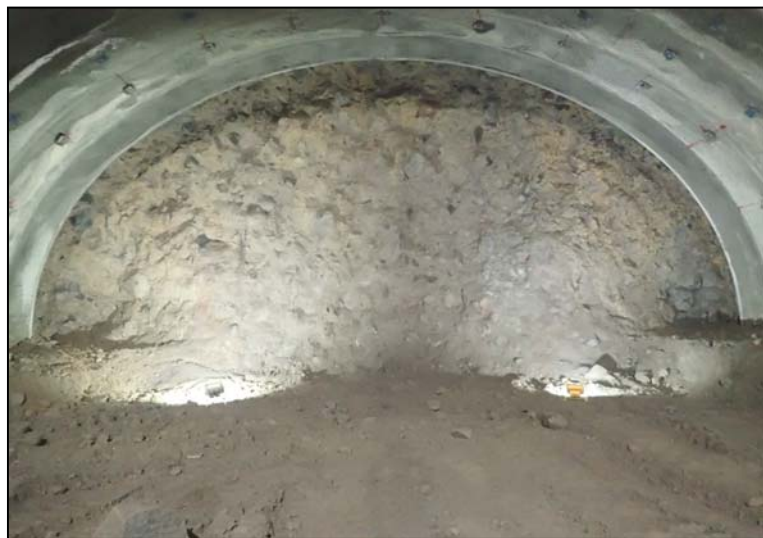
【本坑③切羽状況】
