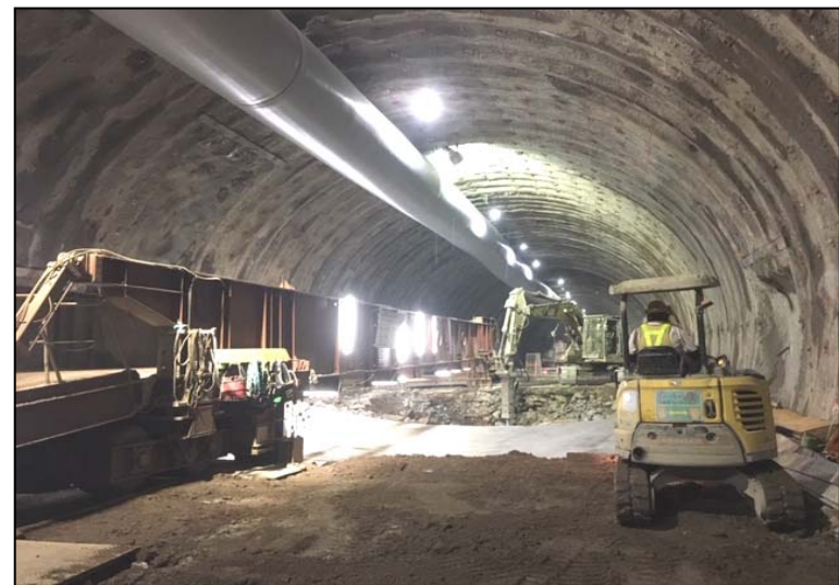
【インバート工施工状況】
