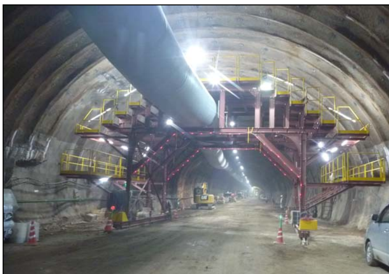
【本坑② 防水シート台車】
